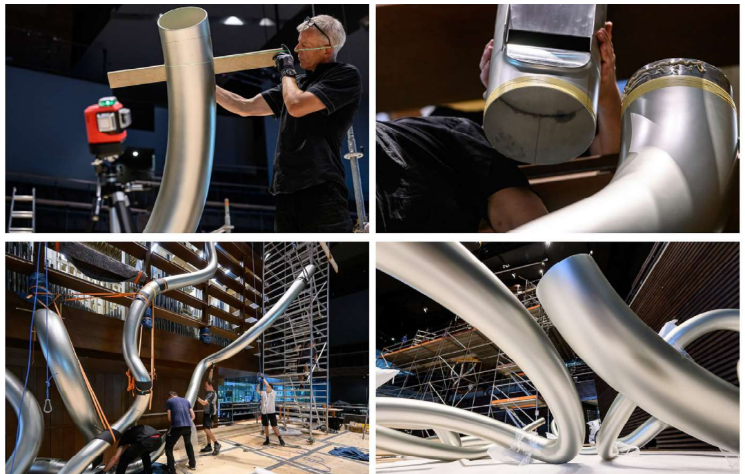
Kesän 2023 merkittävimpiin työvaiheisiin lukeutui urkujen fasadin asennus. Hopeiset elementit valmistettiin 3D-tulostamalla ja ne ovat täysin toiminnalliset: fasadissa on kymmenen soivaa pilliä sekä ilmapanavia. Fasadin suunnittelivat Rieger Orgelbaun designer Harald Schwarz ja urkurakentaja Wendelin Eberle. Harald Schwarz osallistui myös asennustyöhön (ylh.vas.). Kuvat Sakari Röyskö
